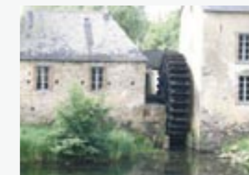
* Moulin du Pont Godalin à Sion-les-Mines
